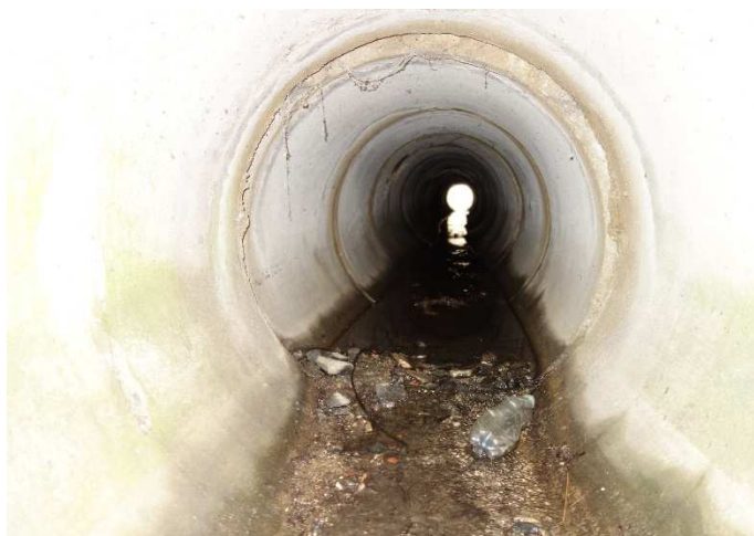
Příčné posunutí trub
